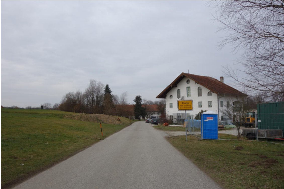
Östl. Ortseinfahrt (rechts im Vordergrund wird ein Einfamilienwohnhaus gebaut, links, oberhalb der Böschung gibt es einen genehmigten Plan für ein Einfamilienwohnhaus)
